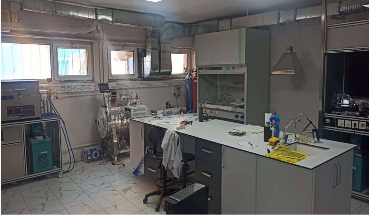
tadilatıC Blok Zemin Kat Kimya Laboratuvarının tadilatı
