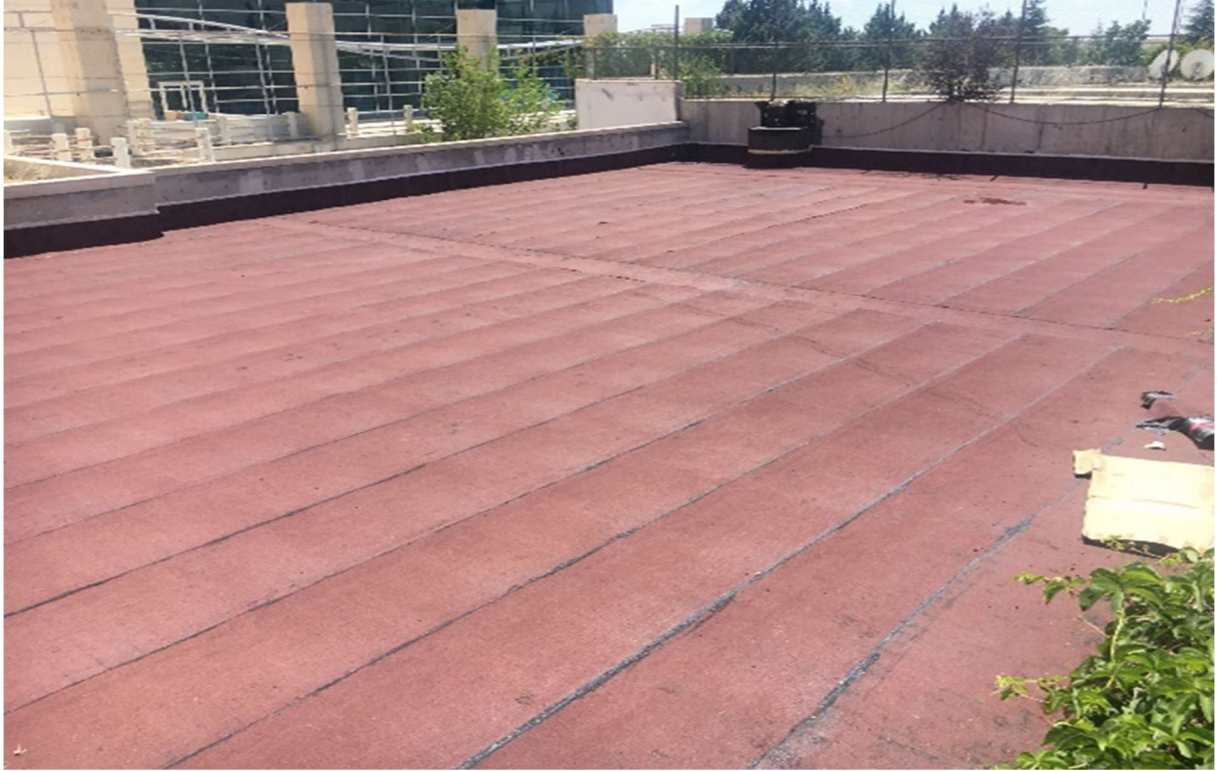
Jeneratör Odası Çatı imalatlarının yenilenmesi
