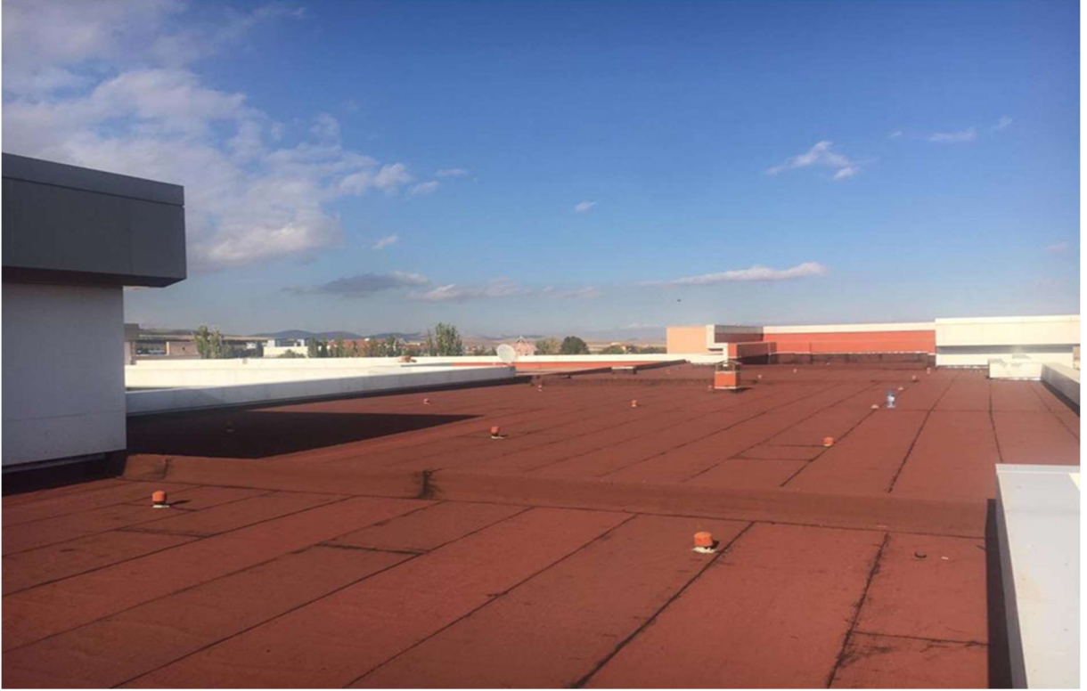
Mühendislik ve Doğa Bilimleri Fakültesi G blok çatı yalıtımının yenilenmesi işi yapılmıştır
