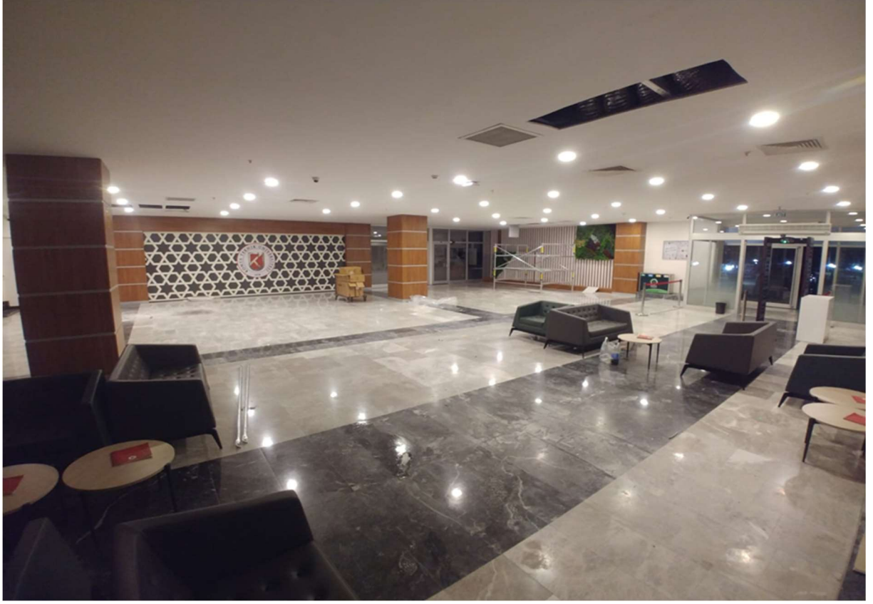
Gelişim Yerleşkesi Rektörlük Girişi Fancoil montajı yapılmıştır.
