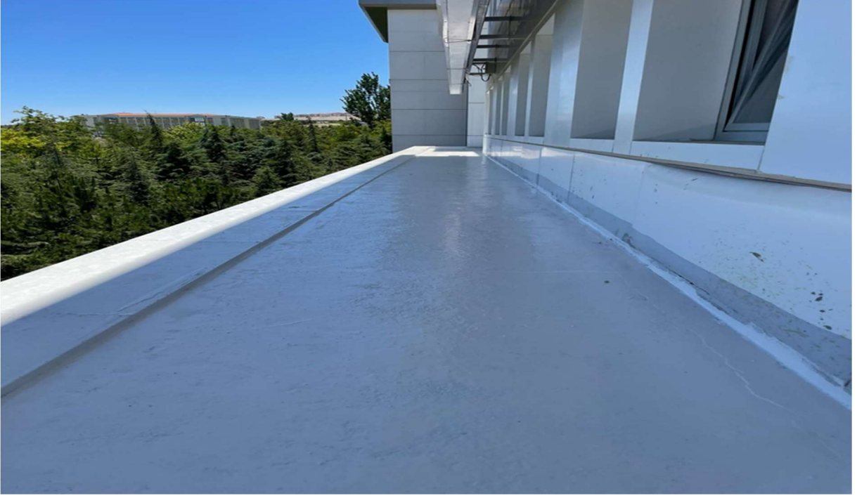
Mühendislik ve Doğa Bilimleri Fakültesi G Blok çıkma üzeri su yalıtımı yapılmıştır. (Şap Betonu Dökülmesi, Poliüretan Uygulaması )
