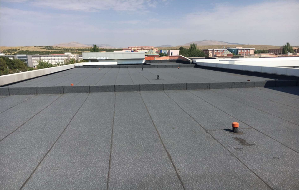
Mühendislik ve Doğa Bilimleri Fakültesi G Blok çatı tadilatı yapılmıştır. Şap Betonunu, Çift Kat Membran
