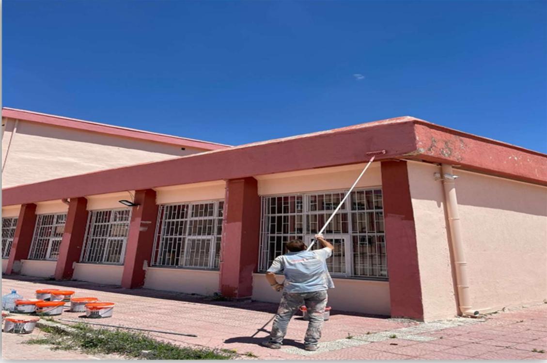
Teknik Bilimler Meslek Yüksekokulu dış cephe tadilatı yapılmıştır.
