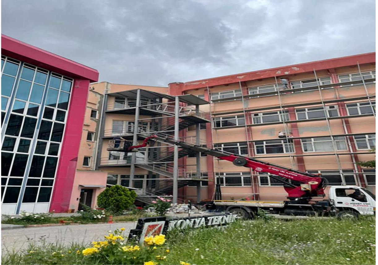
Mühendislik ve Doğa Bilimleri Fakültesi yağmur hattı tadilatı yapılmıştır.
