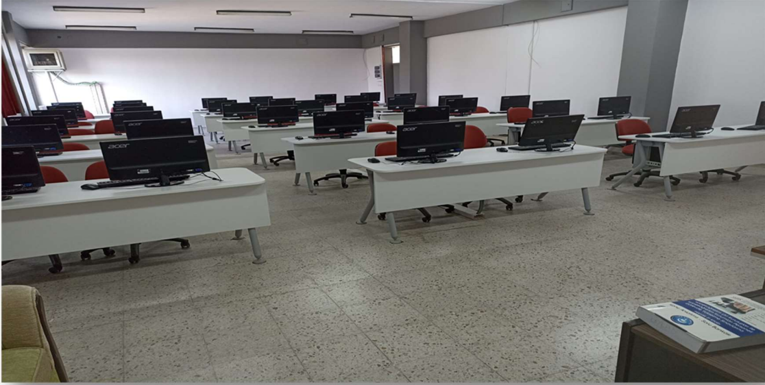
C Blok Zemin Kat 11 nolu laboratuvara kabinet sabitlemesi ve elektrik tesisatı imatları yapılmıştır.
