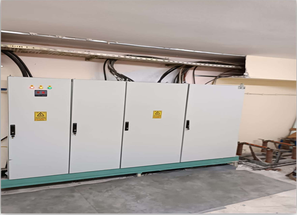
Mühendislik ve Doğa Bilimleri Fakültesi C Blok ana pano imalatı yapılmıştır.
