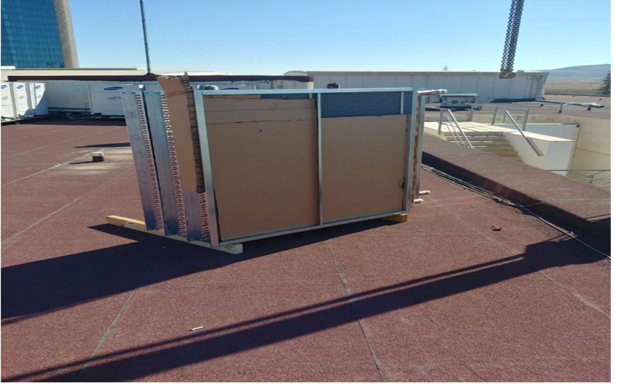
Gelişim Yerleşkesi klima santralleri serpantin değişimleri yapılmıştır
