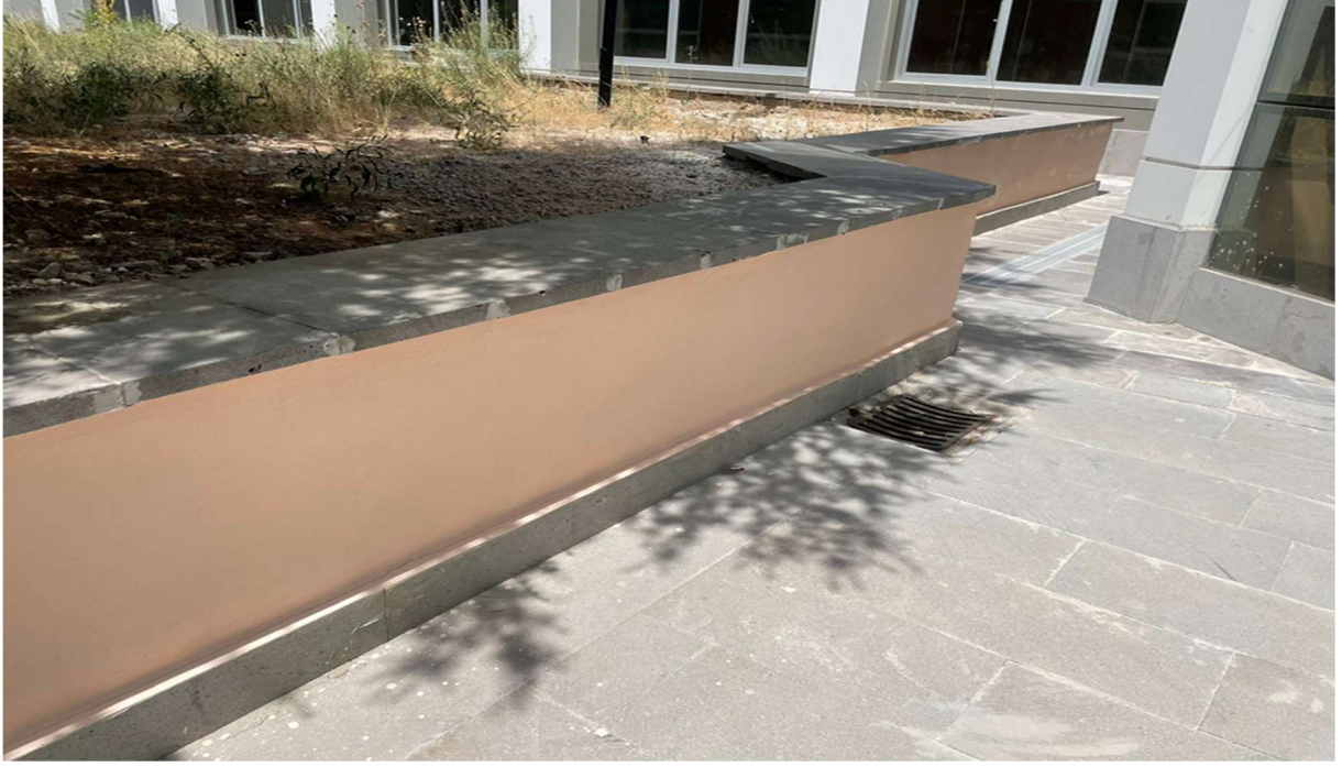
Mühendislik ve Doğa Bilimleri Fakültesi G Blok orta bahçe duvarı tadilatı yapılmıştır. (Sıva Söküm, Dış Cephe Sıvası, Dış Cephe Boyası)
