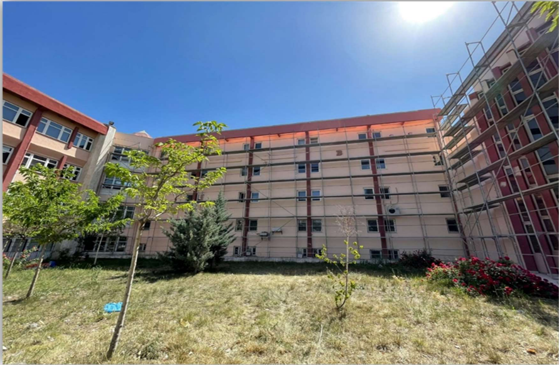
Mühendislik ve Doğa Bilimleri Fakültesi G Blok orta bahçe duvarı tadilatı yapılmıştır. (Sıva Söküm, Dış Cephe Sıvası, Dış Cephe Boyası)
