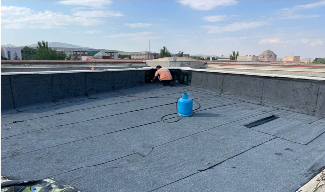
Mühendislik ve Doğa Bilimleri Fakültesi D Blok çatı tadilatı yapılmıştır. (İskele Kalıp Tamirâtı, Çift Kat Membran)
