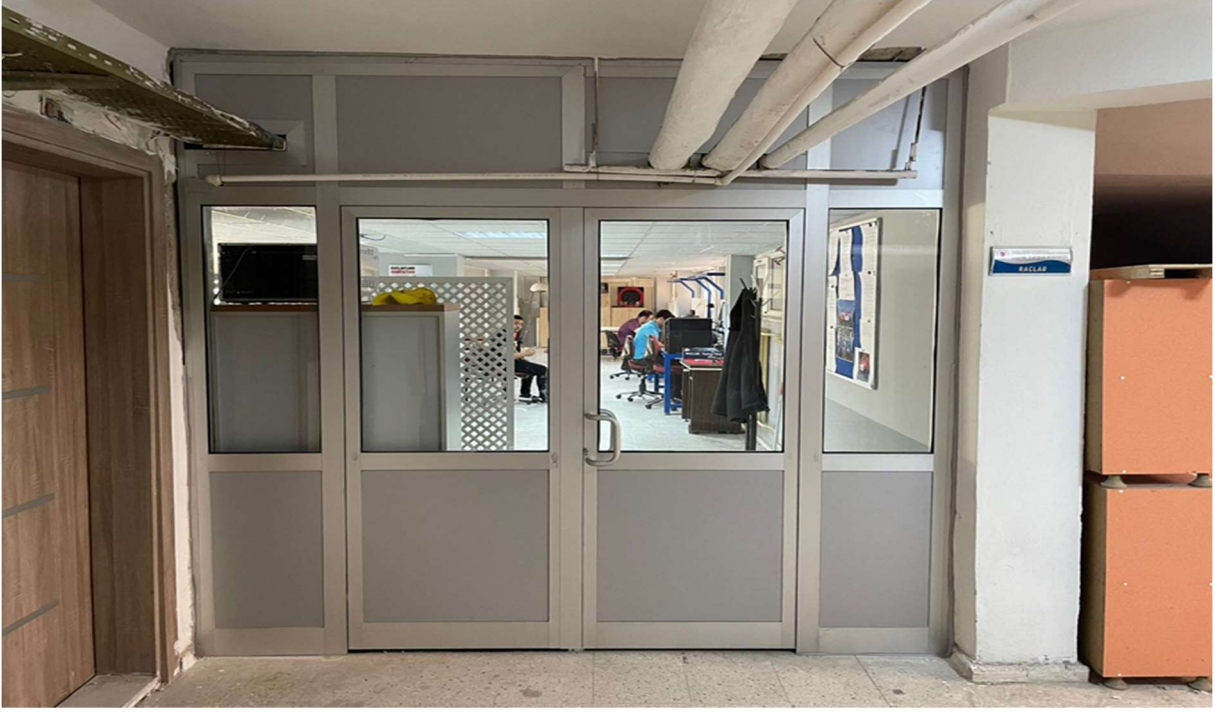
C Blok Bodrum Kat Robotik Otomasyon Kontrol Laboratuvarına alüminyum kapı imalatı ve montajı yapılmıştır. (Çift Kanat Açılır Alüminyum Kapı Uygulaması)
