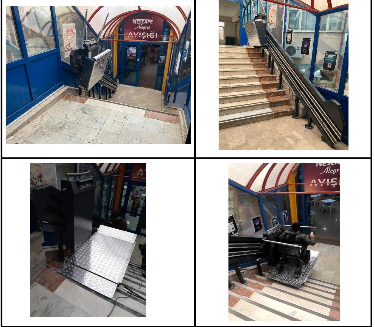
Şekil 17- 2024 Yılı Mühendislik ve Doğa Bilimleri Fakültesi kantinine erişim sağlamak üzere merdiven tipi engelli platformu imalatı.
