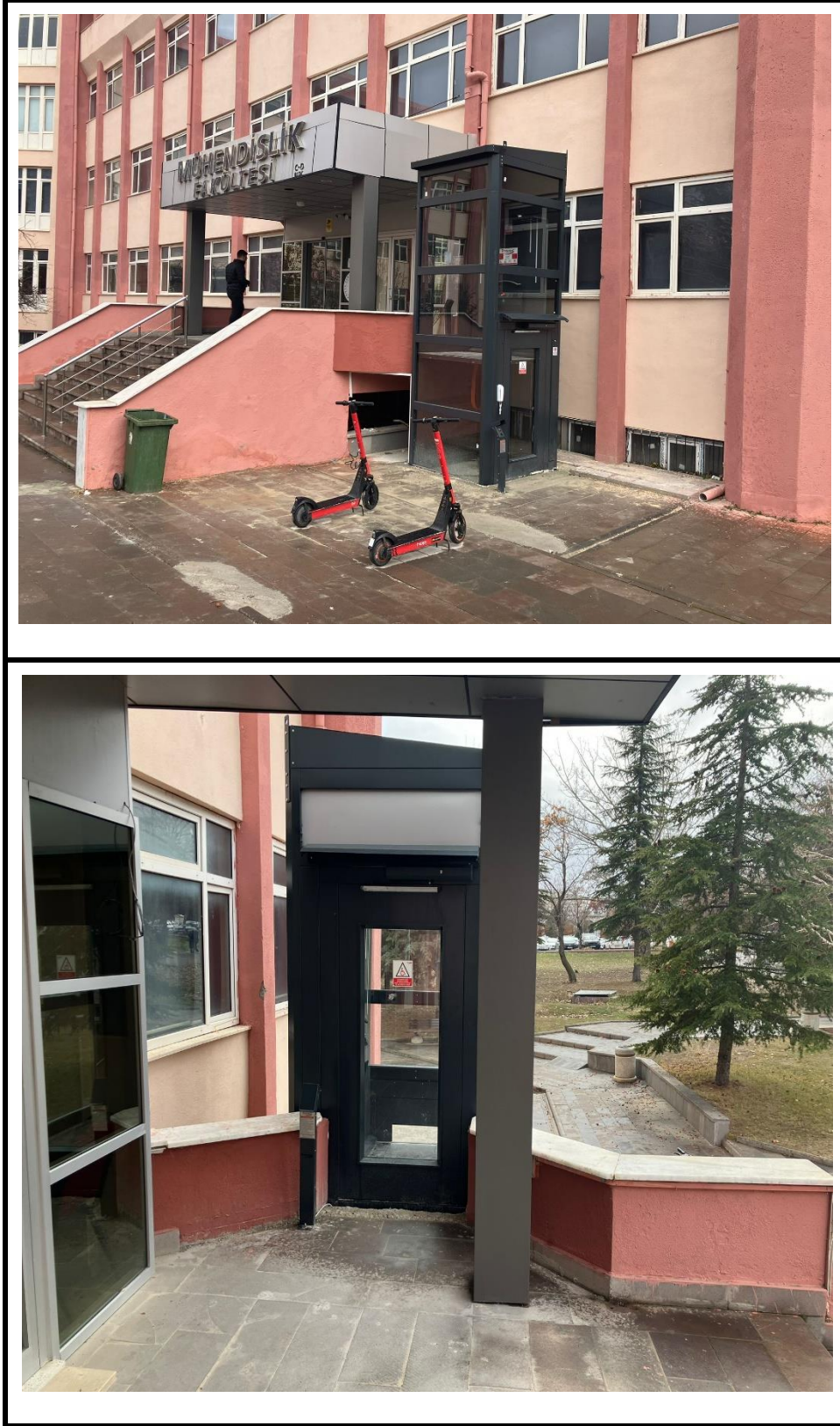
Şekil 18- 2024 Yılı Mühendislik ve Doğa Bilimleri Fakültesi kapalı tip engelli platformu imalatı.
