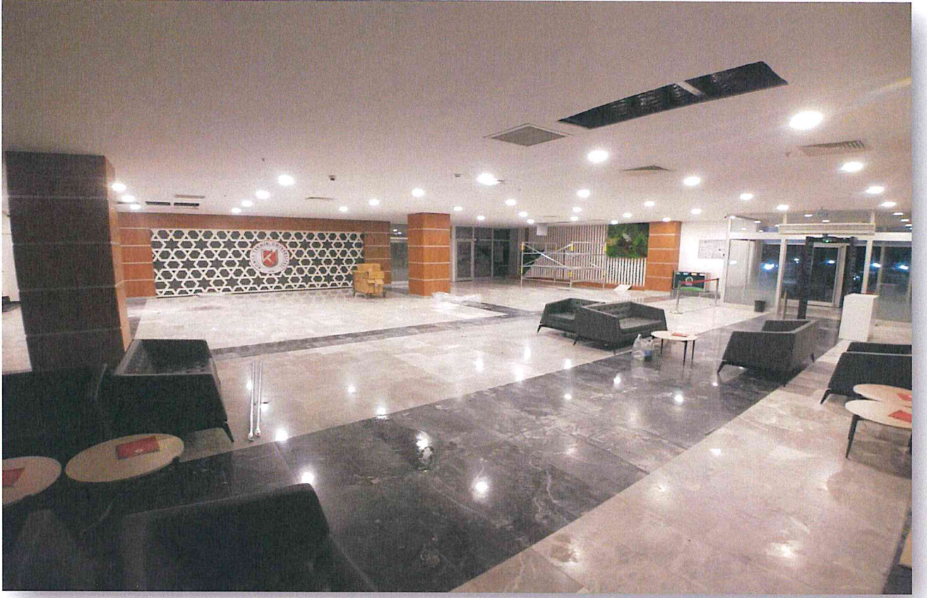
Resim 7: Gelişim Yerleşkesi Rektörlük Girişi Fancoil Montaj Tamamlanıp Devreye Alınmıştır.
