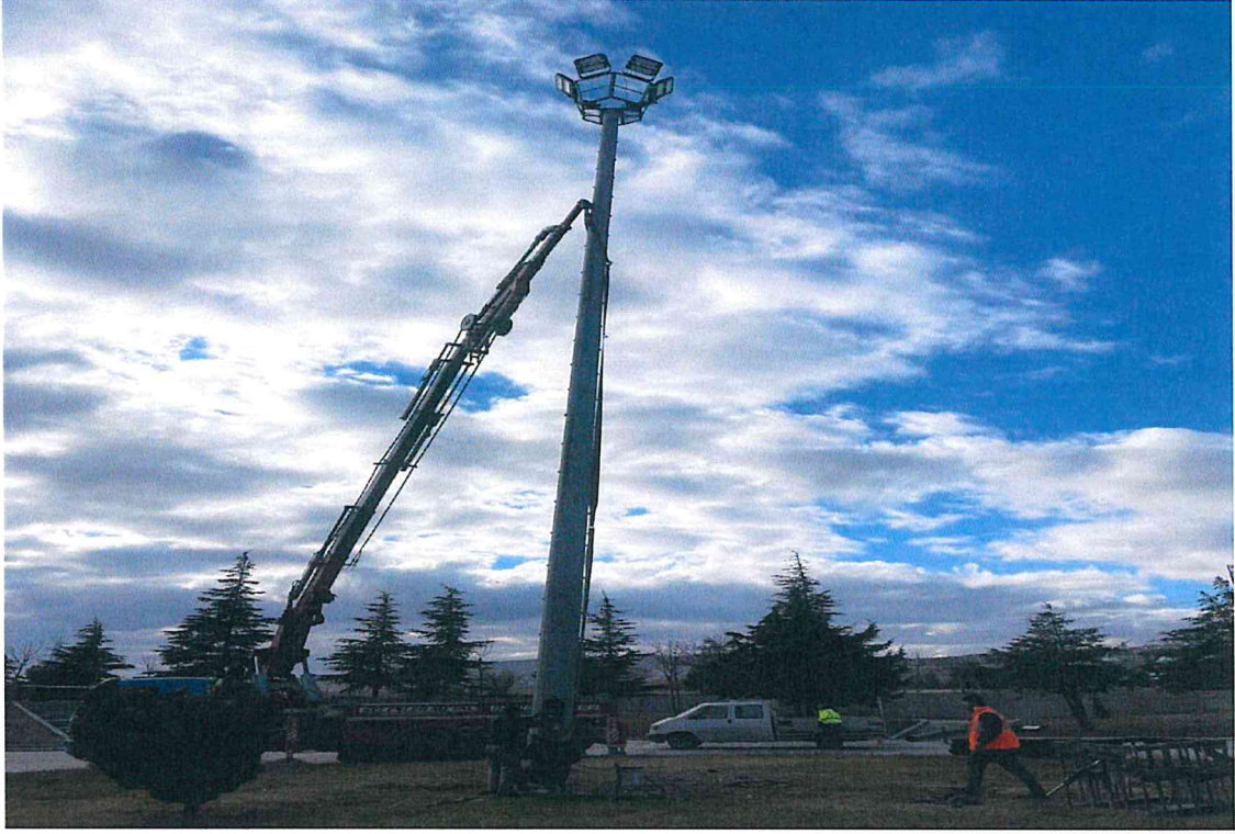
Resim 6: Gelişim Yerleşkesi Projektör Direği Kısaltılması ve Projektörlerin Değiştirilmesi Tamamlanıp Devreye Alınmıştır.
