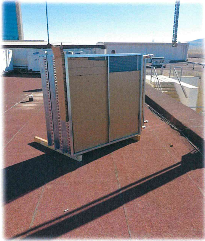
Resim 3: Gelişim Yerleşkesi Klima Santralleri Serpantin Değişimi
