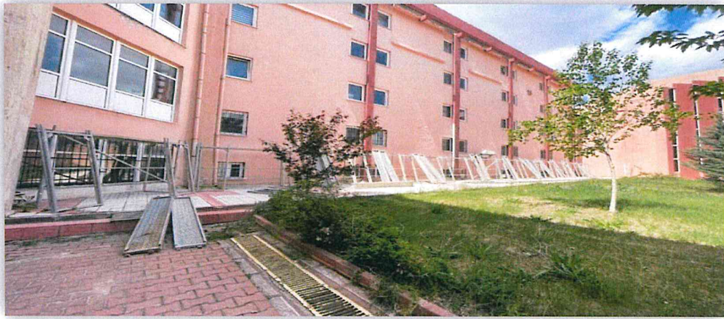
Resim 4: Mühendislik Ve Doğa Bilimleri Fakültesi Dış Cephe Tadilatı Tamamlanıp Devreye Alınmıştır.
