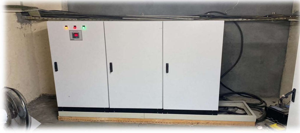
Mühendislik ve Doğa Bilimleri Fakültesi A Bloкта Bulunan Ana Panonun Değişimi İşi
