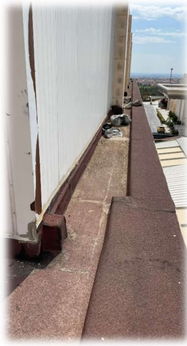
Rektörlük Hizmet Binası / Mimarlık ve Tasarım Fakültesi Binasında Yemekhane ve Konferans Salonu Akıntılarının Kesilmesi Amacı İle Boşlukların Gaz Beton İle Doldurulması, Üzerine Şap Atılması ve Çift Kat Membran İmalatı İşi
