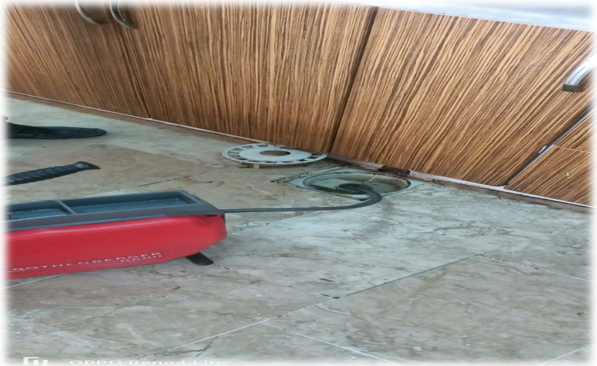
Konya Teknik Üniversitesine Ait Binalarda Tıkanıklık Bulunan Bölgelerde PVC Tıkanıklık Açılması İmalatı İşi
