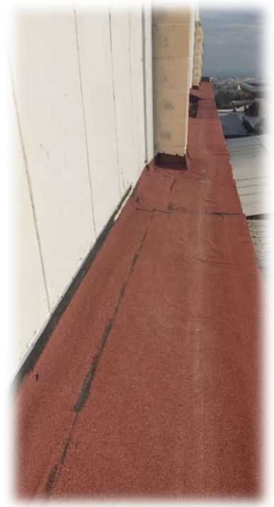
Rektörlük Hizmet Binası / Mimarlık ve Tasarım Fakültesi Binasında Yemekhane ve Konferans Salonu Akıntılarının Kesilmesi Amacı İle Boşlukların Gaz Beton İle Doldurulması, Üzerine Şap Atılması ve Çift Kat Membran İmalatı İşi
