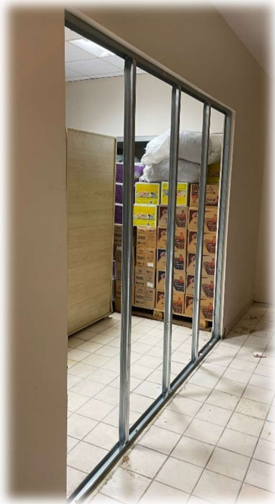
Teknik Bilimler Meslek Yüksekokulu Binası D Blok 2.Kat 212 numaralı Odada Ses Yalıtımlı Bölme Duvar İşi
