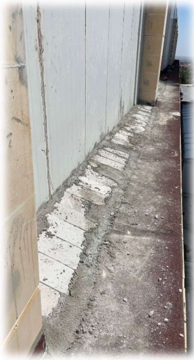
Rektörlük Hizmet Binası / Mimarlık ve Tasarım Fakültesi Binasında Yemekhane ve Konferans Salonu Akıntılarının Kesilmesi Amacı İle Boşlukların Gaz Beton İle Doldurulması, Üzerine Şap Atılması ve Çift Kat Membran İmalatı İşi
