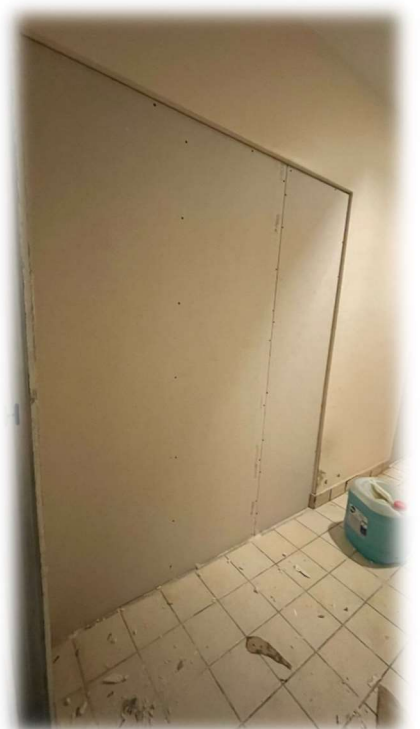
Teknik Bilimler Meslek Yüksekokulu Binası D Blok 2.Kat 212 numaralı Odada Ses Yalıtımlı Bölme Duvar İşi
