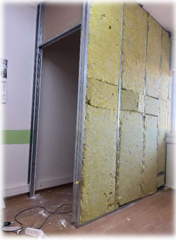
Teknik Bilimler Meslek Yüksekokulu Binası D Blok 2.Kat 212 numaralı Odada Ses Yalıtımlı Bölme Duvar İşi
